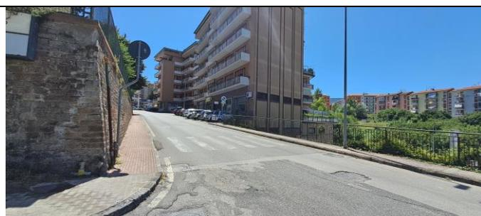
Foto 3: ammaloramento dell'asfalto Via Dei Due Principati
