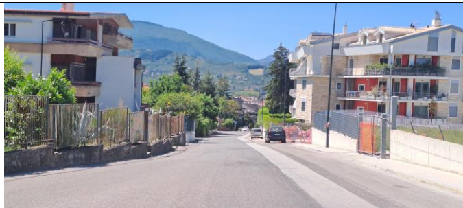
Foto 6: ammaloramento dell'asfalto Via Tuoro Cappuccini
